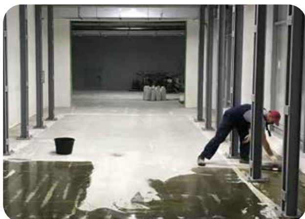
Распределение эпоксидного состава ДенсТоп ЭП 500
