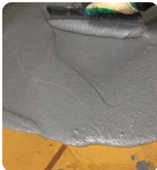
Распределение цементно-полиуретанового состава ДенсТоп ПМ 605 Флоу АС
