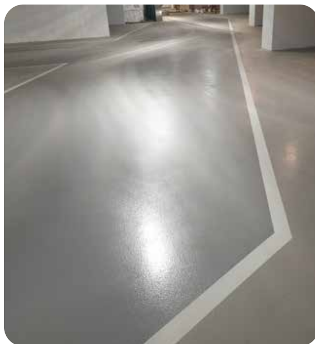
Внешний вид поверхности эпоксидного покрытия ДенсТоп ЭП 501 с нанесенными линиями разметки
