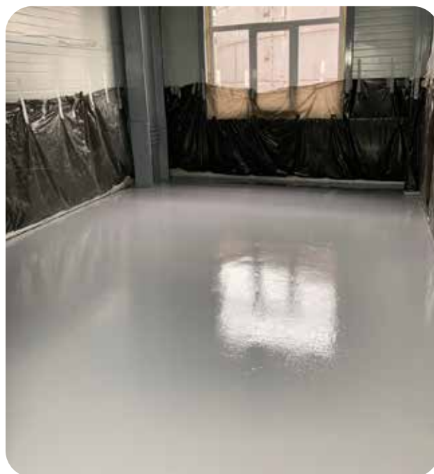
Финишный вид тонкослойного эпоксидного покрытия ДенсТоп ЭП 201
