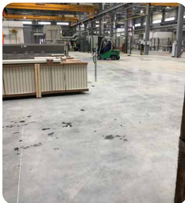
Вид бетонного пола с упрочненным верхним слоем в процессе эксплуатации
