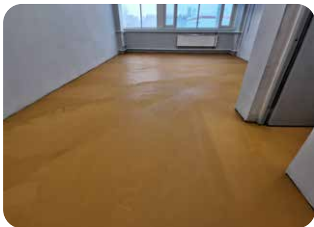
Основание загрунтованное цементно-полиуретановым составом ДенсТоп ПМ 601
