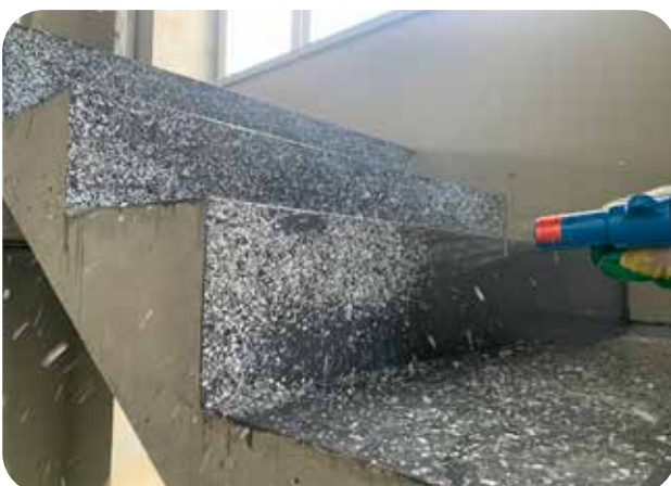
Нанесение цветных флоков механизированным способом
