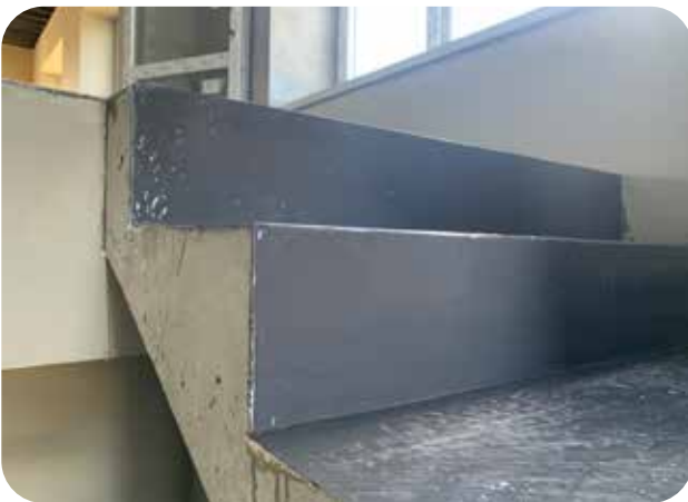
Вид нанесенного полиуретанового покрытия ДенсТоп ПУ 302
