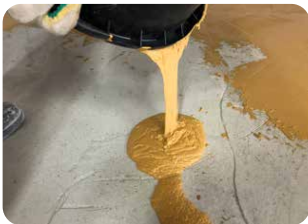
Грунтование поверхности составом ДенсТоп ПМ 601
