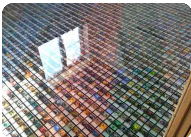
Карточки от настольной игры, приклеенные к основному слою и запечатанные прозрачным эпоксидным составом ДенсТоп ЭП 400
