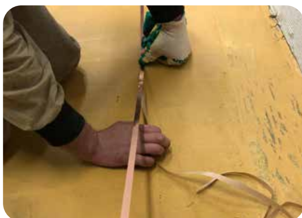
Приклеивание медной токопроводящей ленты на загрунтованное основание
