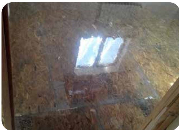
Вид загрунтованного основания ДенсТоп ЭП 104
