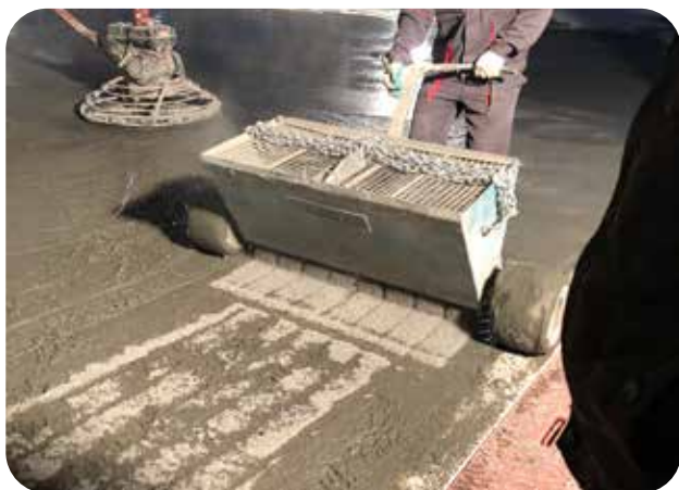
Распределение упрочняющей смеси Стармекс Топ КР скридбоксами
