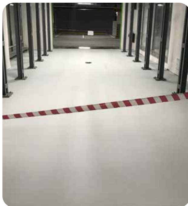
Финишный вид покрытия ДенсТоп ЭП 500 после нанесения полиуретанового лака ДенсТоп ПУ 310
