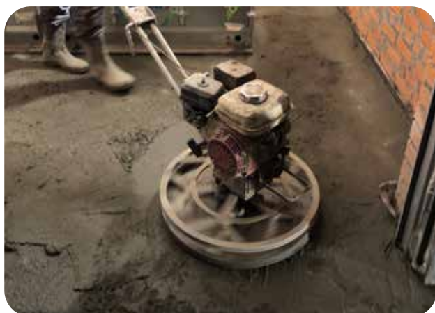
Затирка топпинга специальными машинами (вертолётami)
