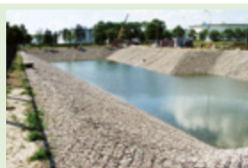
2004 Орлен Ко Пожарный пруд на складе горючих веществ Польша 7.000 м 2
