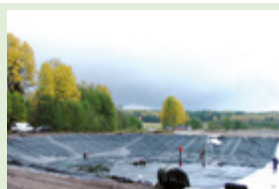
2004 Полигон хранения отходов Дьюпдален Аэрационный пруд для выщелачивания воды Швеция 4.800 м 2
