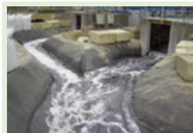
2005 Денис-Персин Аквафин Водоочистной бассейн Бельгия 2.500 м 2
