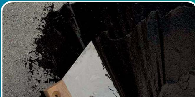
ГИДРОИЗОЛЯЦИЯ ПРИМЫКАНИЯ ПЛИТЫ К ВЕРТИКАЛЬНЫМ КОНСТРУКЦИЯМ
