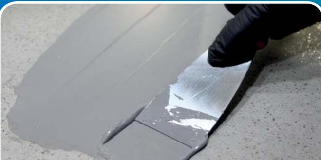
ГИДРОИЗОЛЯЦИЯ ПРИМЫКАНИЯ ПЛИТЫ К ВОДООТВОДНОЙ ТРУБКЕ
