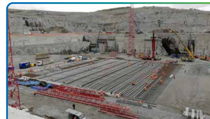
Центр строительства крупнотоннажных морских сооружений, сухой док и перемычка, г. Мурманск
